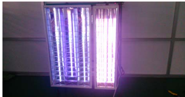
ภาพที่ 4 การติดตั้งหลอดแอลอีดีกับ โคมไฟ
