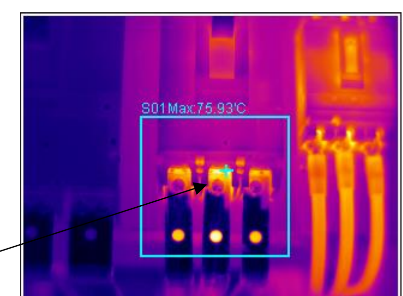
ภาพเปรียบเทียบอุปกรณ์ทางไฟฟ้าก่อนและหลังการใช้กล้องส่องความร้อน
